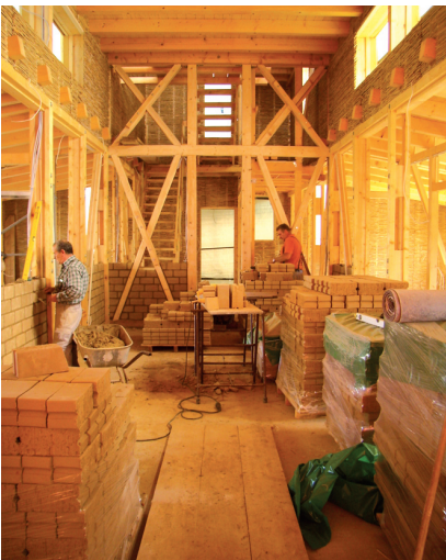
Ausmauern der Innenwände
