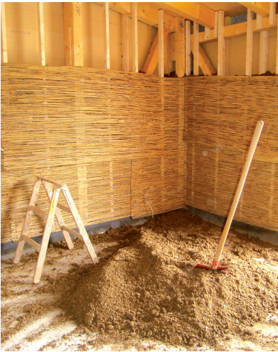
Leichtlehmfüllung der Außenwände
