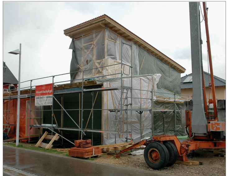
Im Herbst musste der Bau für die Innenarbeiten vor Wind und Wetter geschützt werden.
